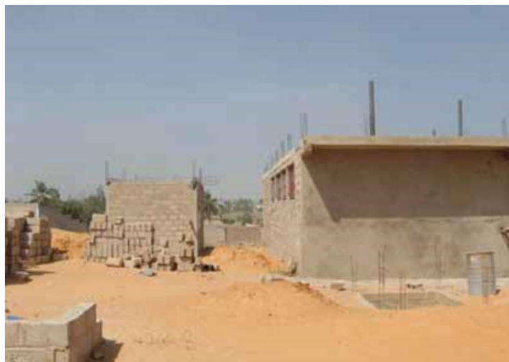
Parpaings et chantier de construction dans la banlieue de Dakar Source : Université Laval 2007
