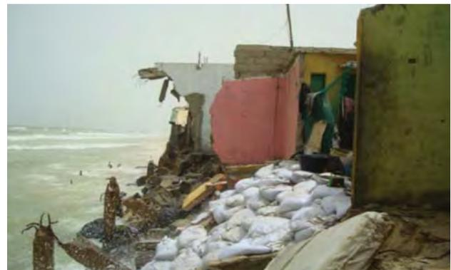
Photo 23 : Dégâts occasionnés par les houles et les vents à Nguet Ndar (Source, DEEC, 2014).
