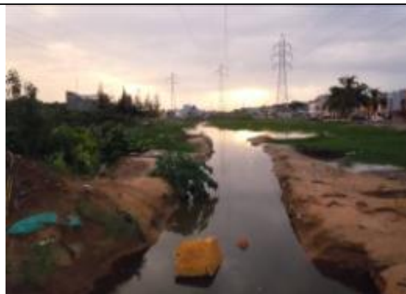
Photo 2: Emprise tracé PROGEP à Dalifort (le 24/09/11)
