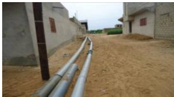
Pompage des eaux pluviales à la Cité Municipale
