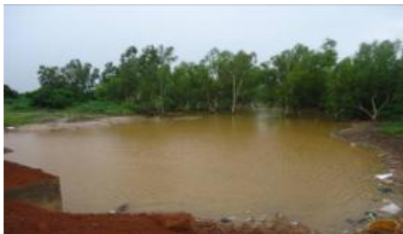
Ouvrage OH.08 sur l'autoroute
