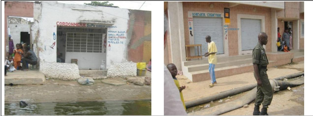
**Photo 21& 22 : Boutique avec muret de protection à l'entrée et Construction avec un accès rehaussé**
