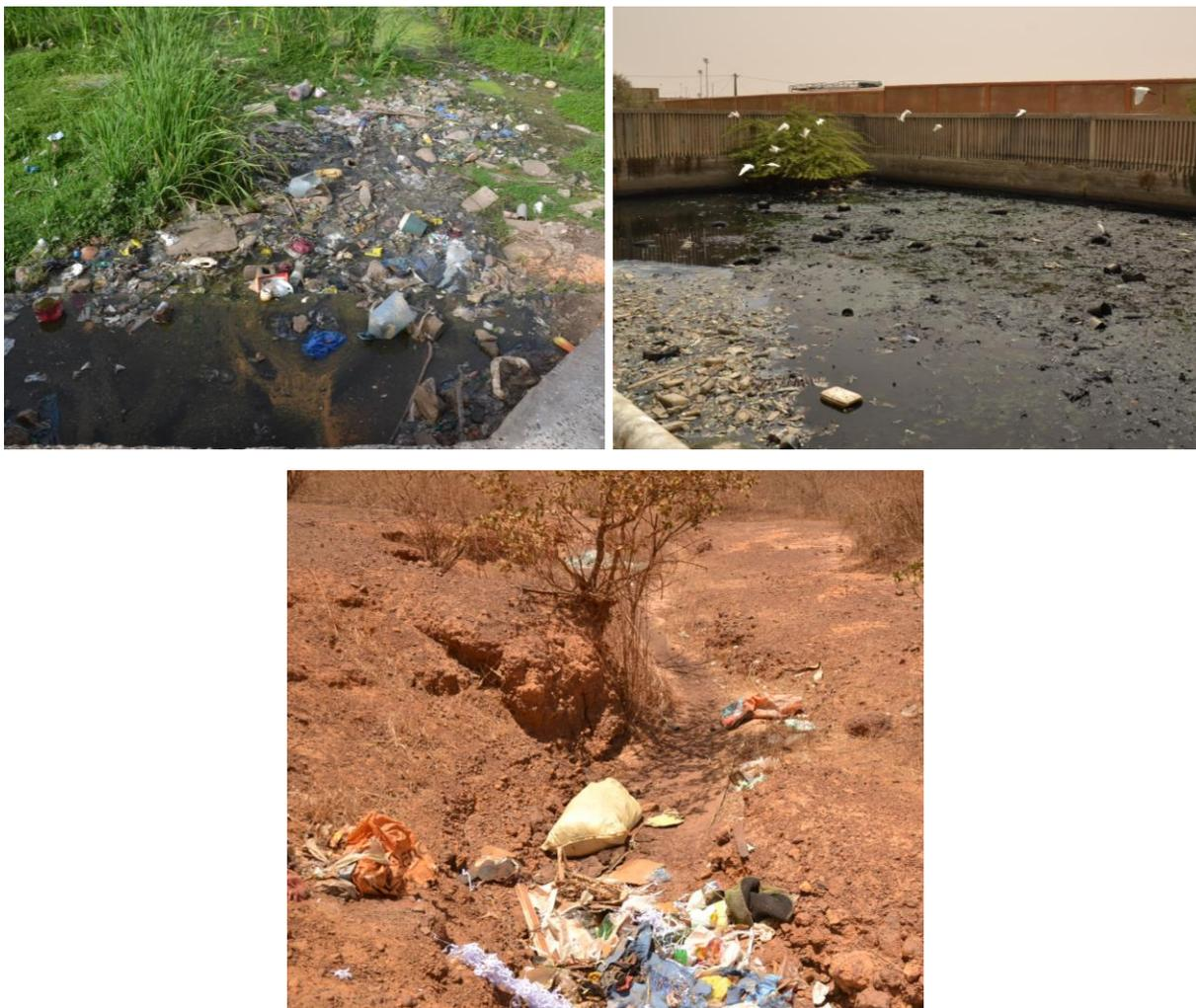
**Figure 15. Accumulation de déchets dans différents ouvrages destinés à la gestion des eaux pluviales.**
