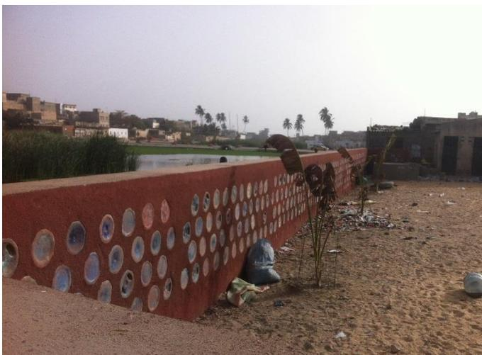
**Photo 7.** Érection d'un mur en béton construit à partir de bidons remplis de déchets solides collectés dans le quartier
