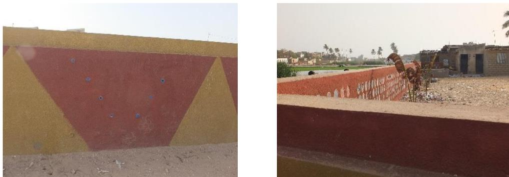
**Figure 20 Mur en éco-brique construit dans la commune de Yeumbeul Nord, dans la banlieue de Dakar pour fermer l'enceinte d'une école. A gauche, la partie du mur visible depuis la rue. A droite, la partie du mur visible depuis l'enceinte de l'école (Source : E. Colbert).**
