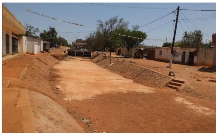
**Figure 21** Au cœur de la commune de Diass, partie terminale du canal d'évacuation des eaux pluviales construit dans le cadre du projet d'aéroport (Source : E. Colbert)
