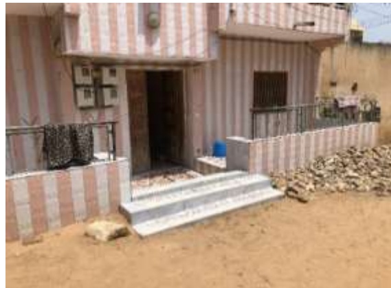
Exemple de courette anglaise mise en place par des habitants (Djaka Djanor)
