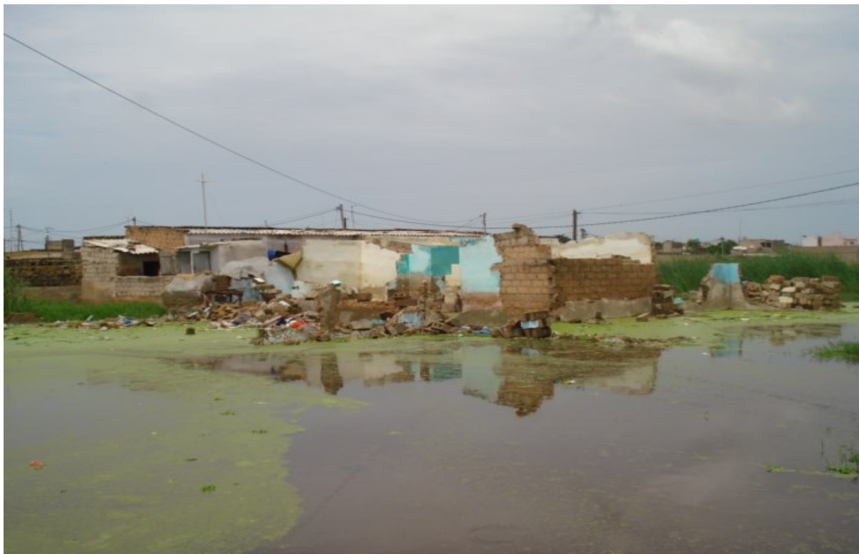
Figure 14:Image bâtiment endommagé par l'inondation
