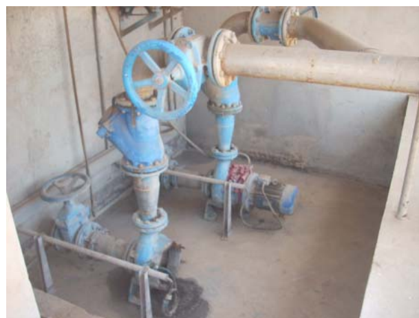
Pompage boues primaires
