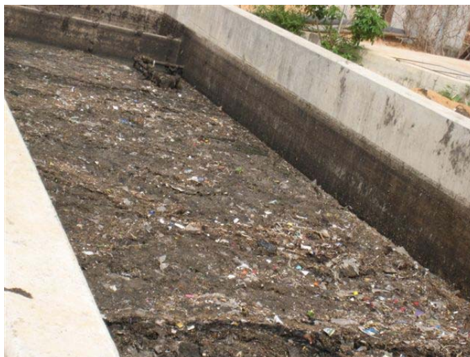
Bassin de sédimentation dépositrice de Cambérène en fonctionnement
