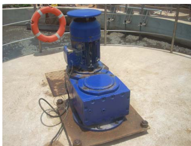
Moteur des turbines d'aération (1/2)
