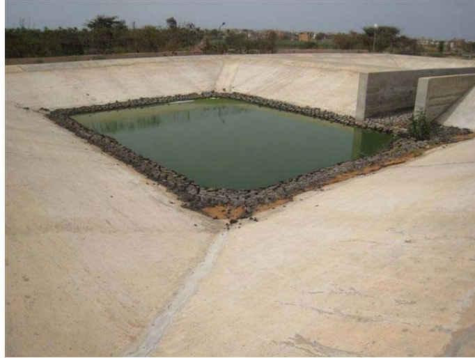
Bassin anaérobie déposante des Niayes
