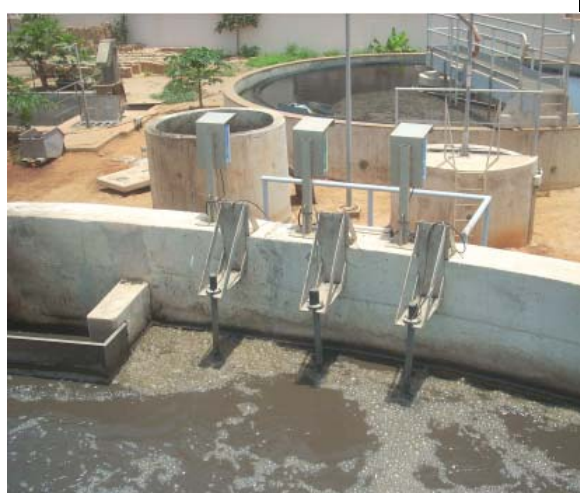
Sondes de mesure sur le bassin d'aération
