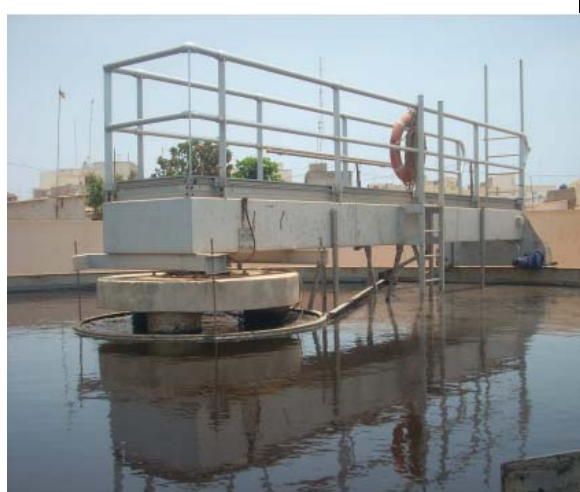
Pont racleur du clarificateur
