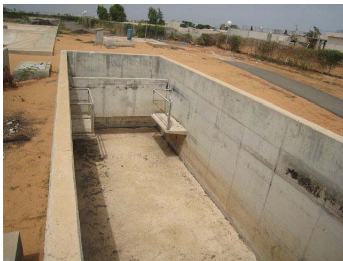
Bassin de sédimentation déposante des Niayes à l'arrêt
