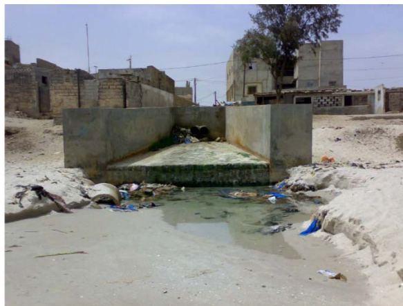
Point N°12 Bassin Tivaoune Diacksao Thiaroye
