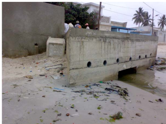
Point N°8 Bassin zone de captage
