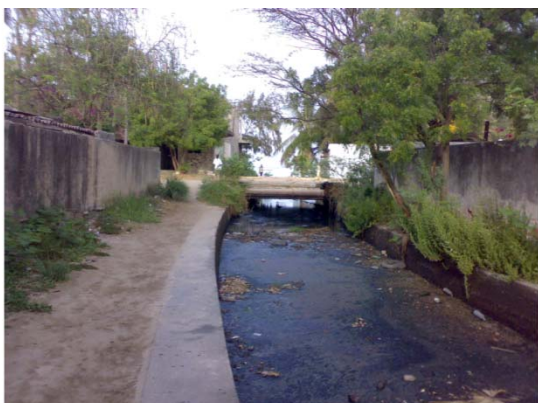
Point N°9 Canal VI Baie de Hann
