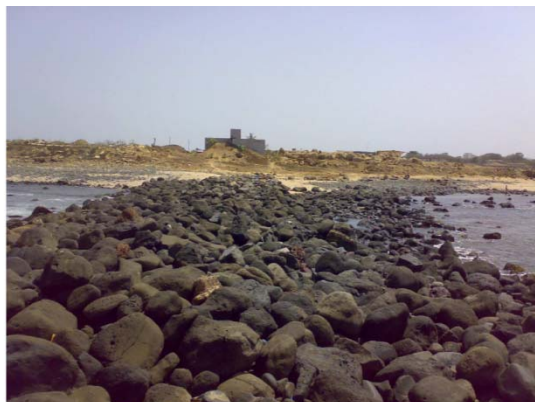
Point N°1+2 Siphon en mer Université + Soubédioune
