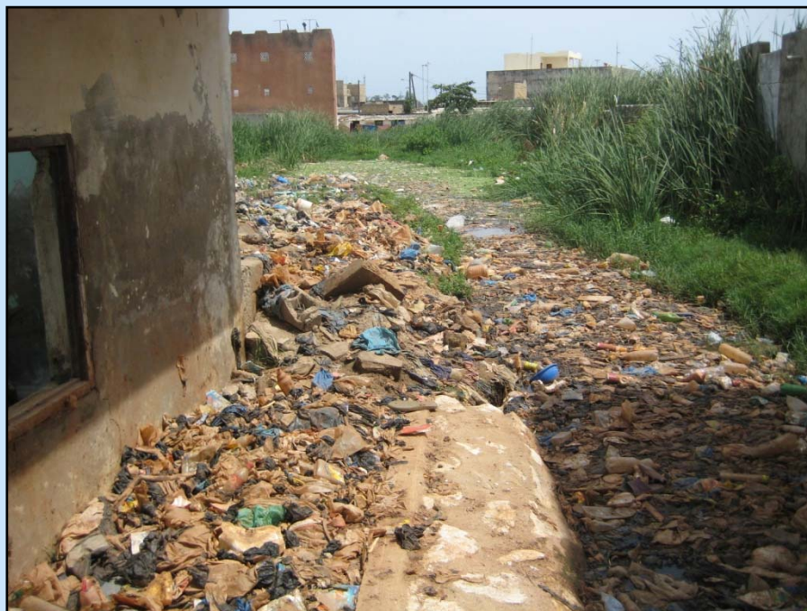
Canal avec difficulté de maintenance
