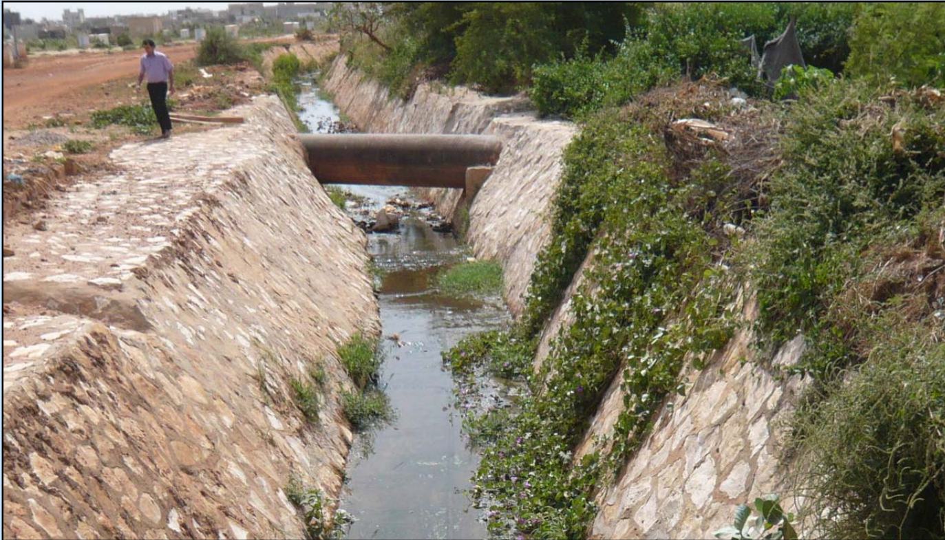
Conflit avec réseau AEP
