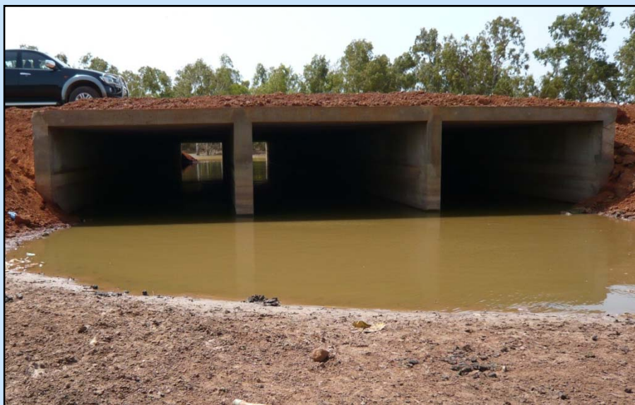
Ouvrage sous l'autoroute
