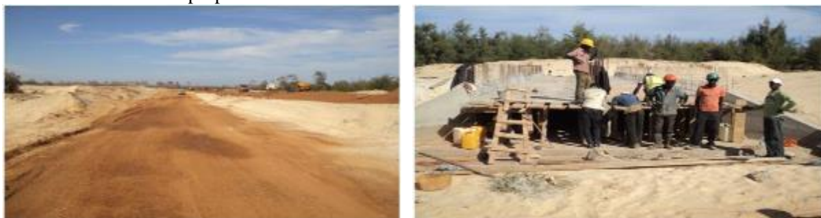
Le chantier de la VDN et le canal en béton armé pour accueillir le future émissaire à la traversée de la VDN
