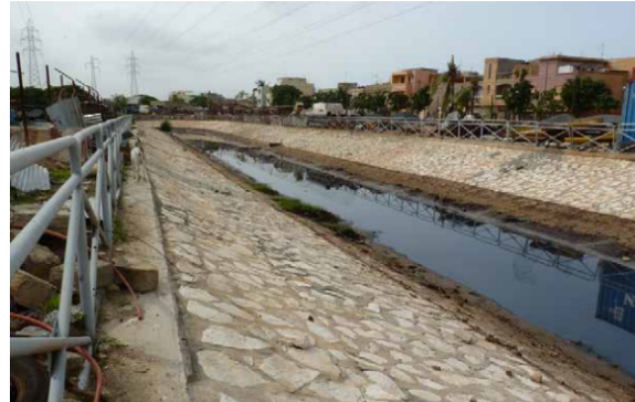
Canal de drainage à Dalifort-Foirail, qui permet l'écoulement des eaux pluviales vers la mer. Source : ADM
